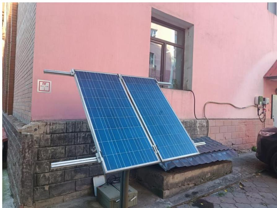
Рисунок 3 – Действующая зарядная станция для электросамокатов
