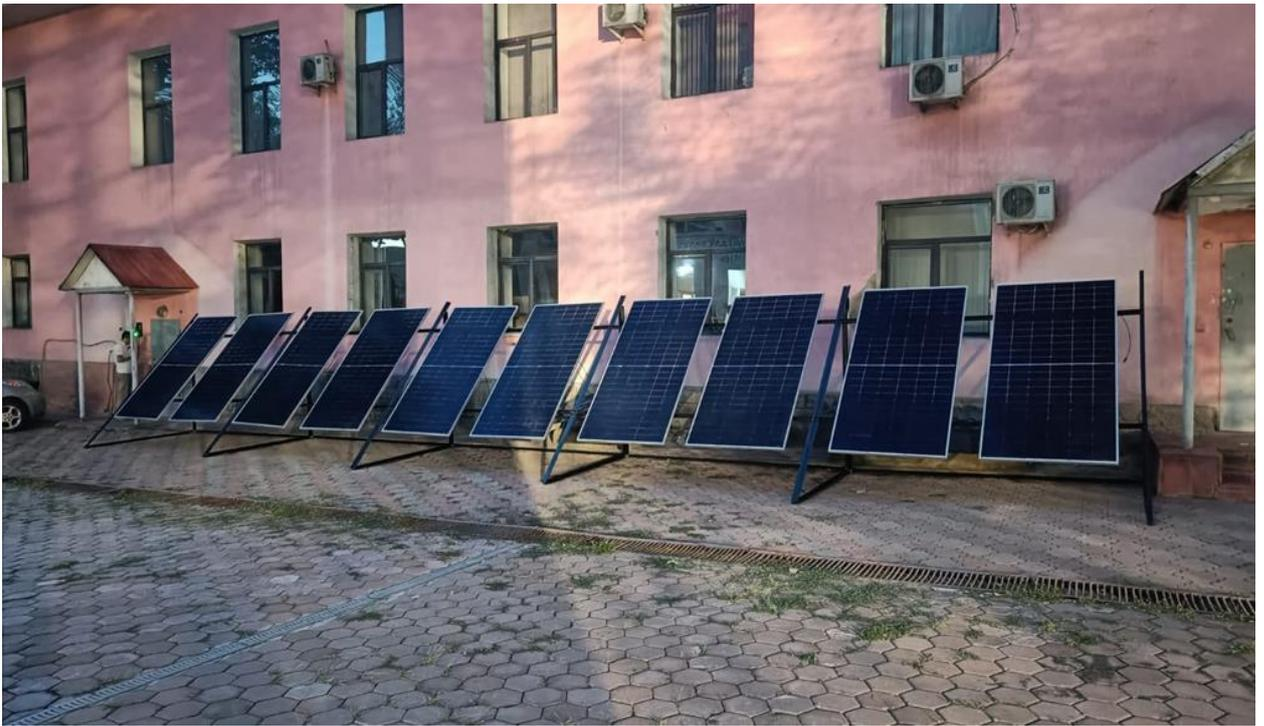
Рисунок 13 – Предлагаемый вариант каркаса автономной зарядной станции
